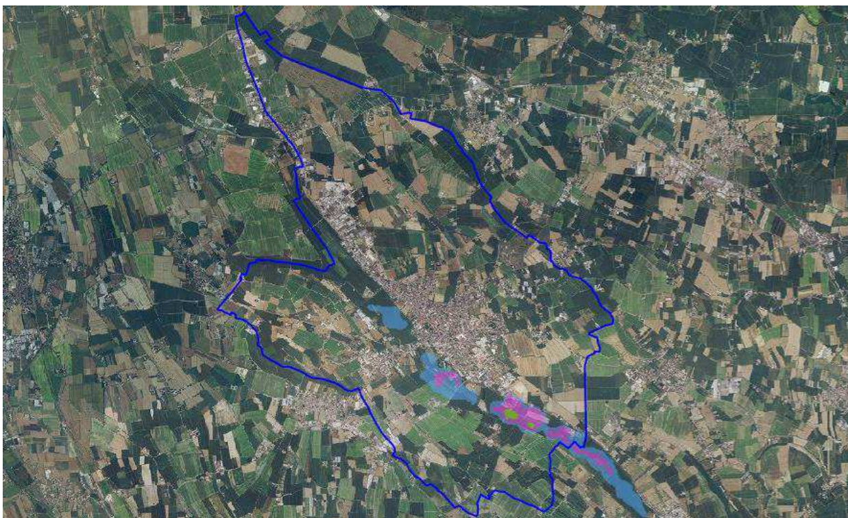
Figura 51 – Zone di distribuzione (P1, P2, P3) all'interno del Comune di Bovolone – Consorzio di Bonifica
