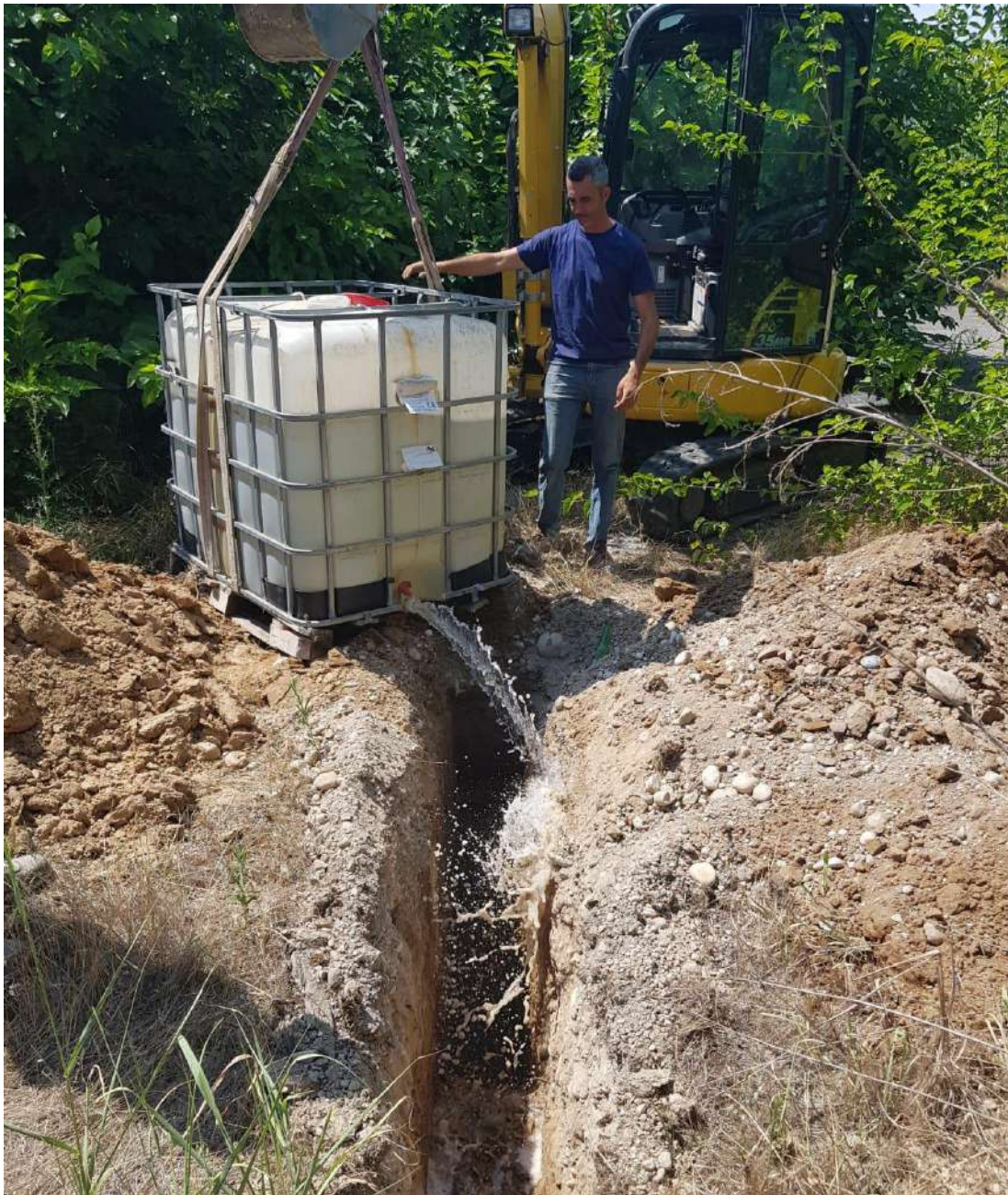
FOTO 7 = Particolare della prova di permeabilità nel Pozzetto geognostico P2
