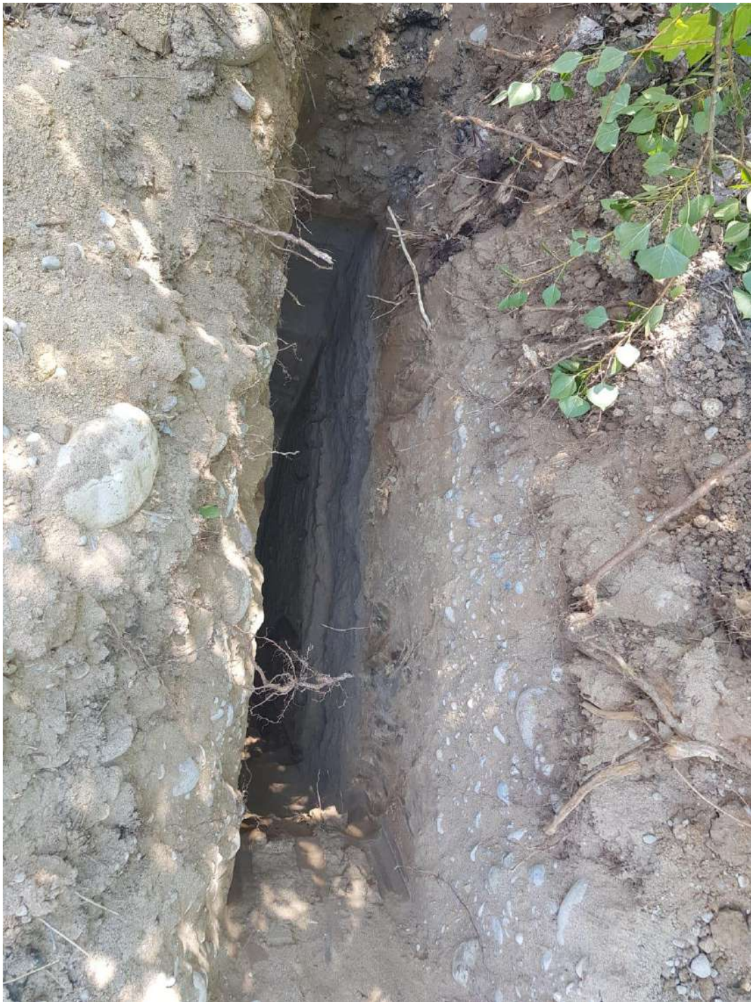
FOTO 5 = Pozzetto geognostico P1
